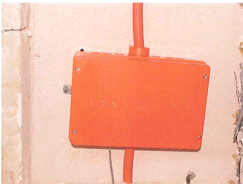
Foto 2: Probekörper „WKE 5“ (geschlossen) vor Durchführung der Brandprüfung gemäß DIN EN 12101-3: 2002
